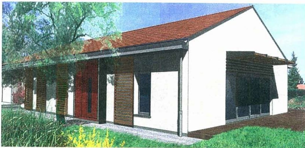
L'aspect traditionnel cache une maison à ossature bois et bottes de paille.
