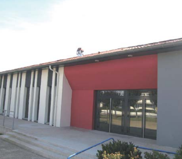
Entrée du bâtiment
