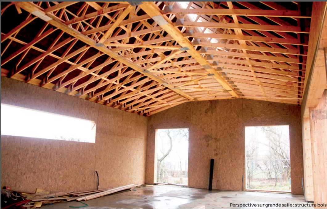
Perspective sur grande salle: structure bois
