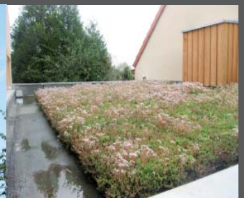
Terrasse végétalisée sur sanitaires
