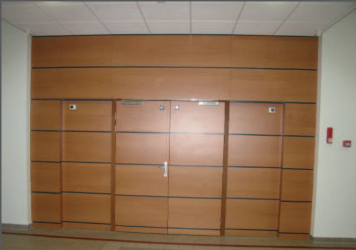
Ensemble bois dans dégagement - accès escalier portes fermées
