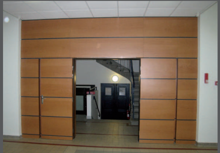
Ensemble bois dans dégagement - accès escalier portes ouvertes
