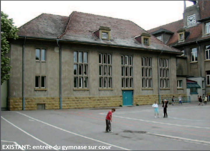
EXISTANT: entrée du gymnase sur cour
