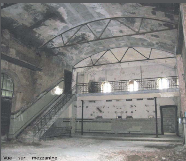
Vue sur mezzanine
