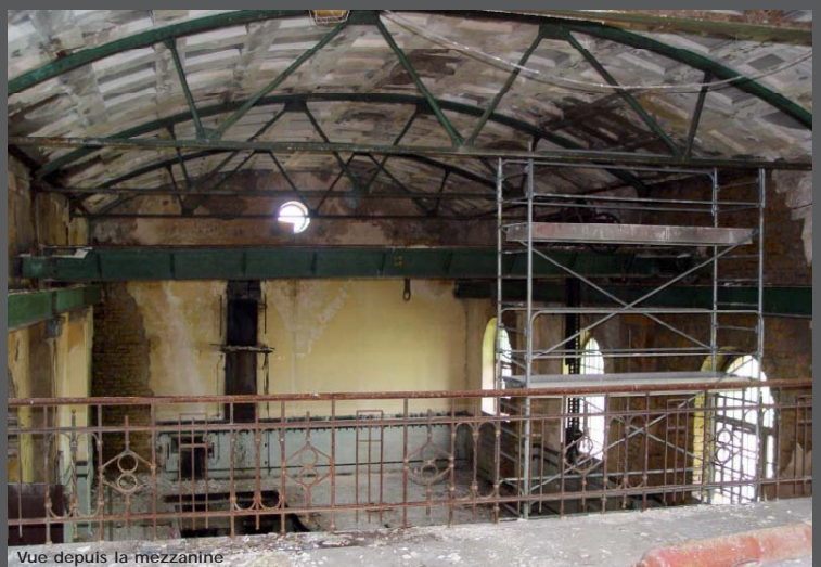
Vue depuis la mezzanine
